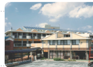
昭和62年 幼老合築施設完成
